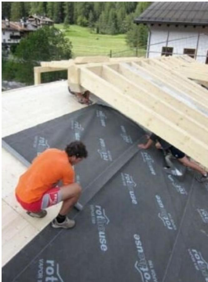
Stock Membrana traspirante Vapor Dach 150, tessuto impermeabile a tre strati in polipropilene ideale per sotto tetti e/o tegole
