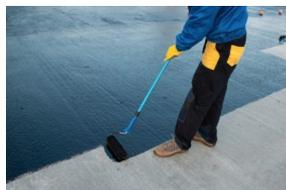
Black Primer è una guaina bituminosa liquida a base solvente con elevate proprietà di ancoraggio, antipolvere e impermeabilizzazione. La guaina è di ottima qualità ed è adatta a isolare coperture strutturali o saturare le porosità del cemento.
