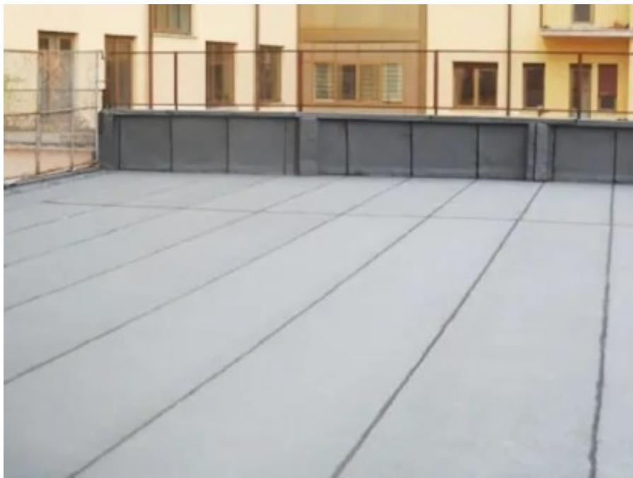
La membrana ardesiata, fornibile standard o adesiva, si differenzia da quelle normali in particolare per la finitura superficiale, che ne allunga la durata e ne migliora l'aspetto estetico. Oltre alla buona impermeabilizzazione, coadiuva l'isolamento termico e garantisce maggiore durata alla struttura.
